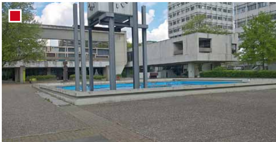
Rathausvorplatz mit großem Wasserbecken und Uhr. Dahinter der Sitzungstrakt und die beiden Türme.
